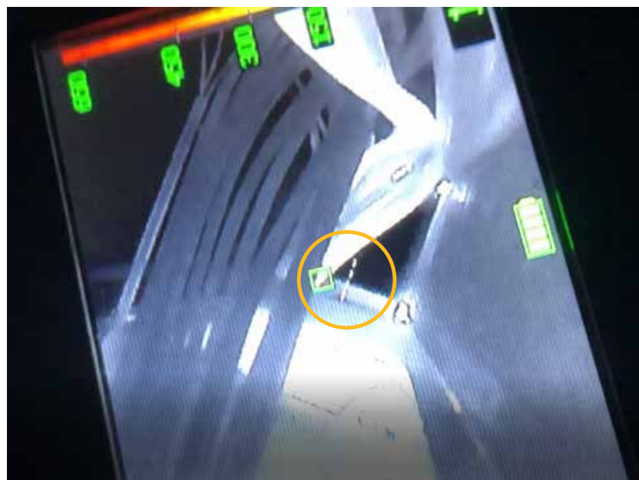
Rökdykarna filmar i kabelrännan under elcentralen och kan notera att något varmt droppar ner på golvet (det inringade området).
