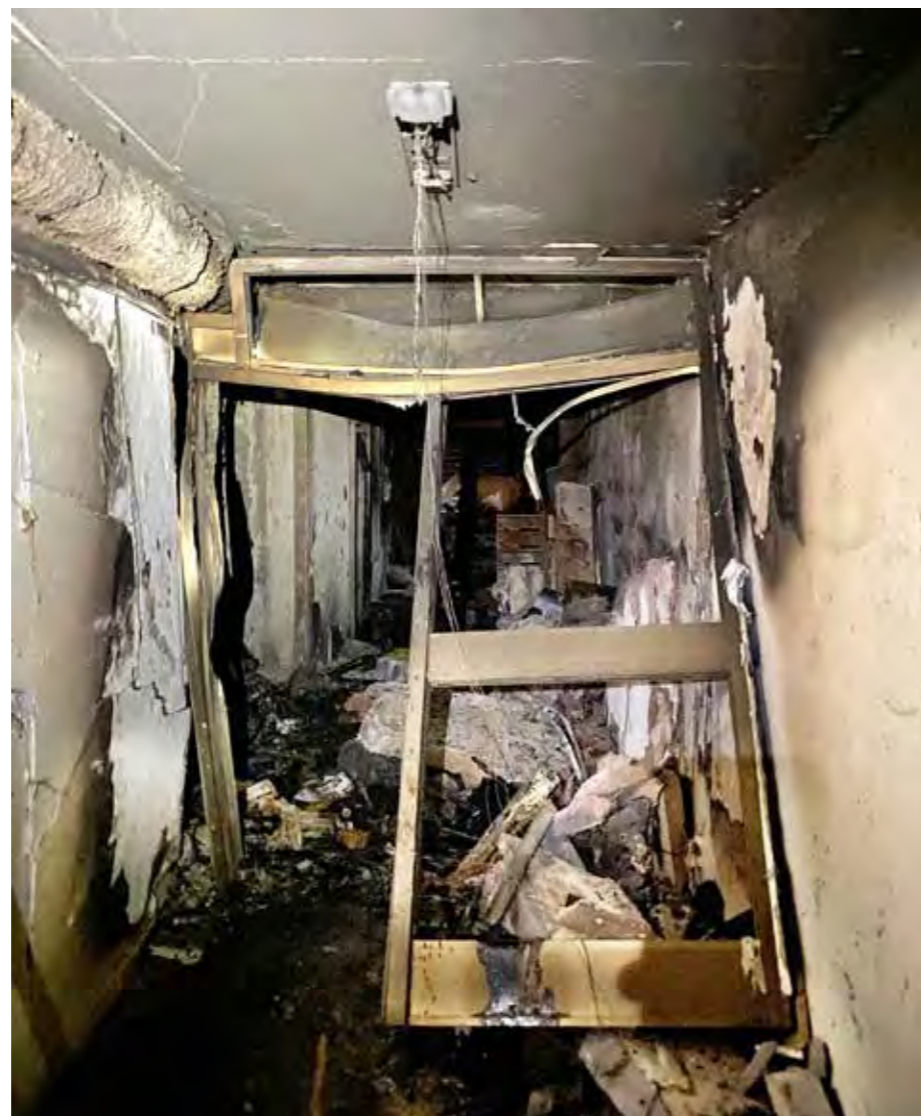
Hela den aktuella byggnaden behöver en omfattande renovering.
