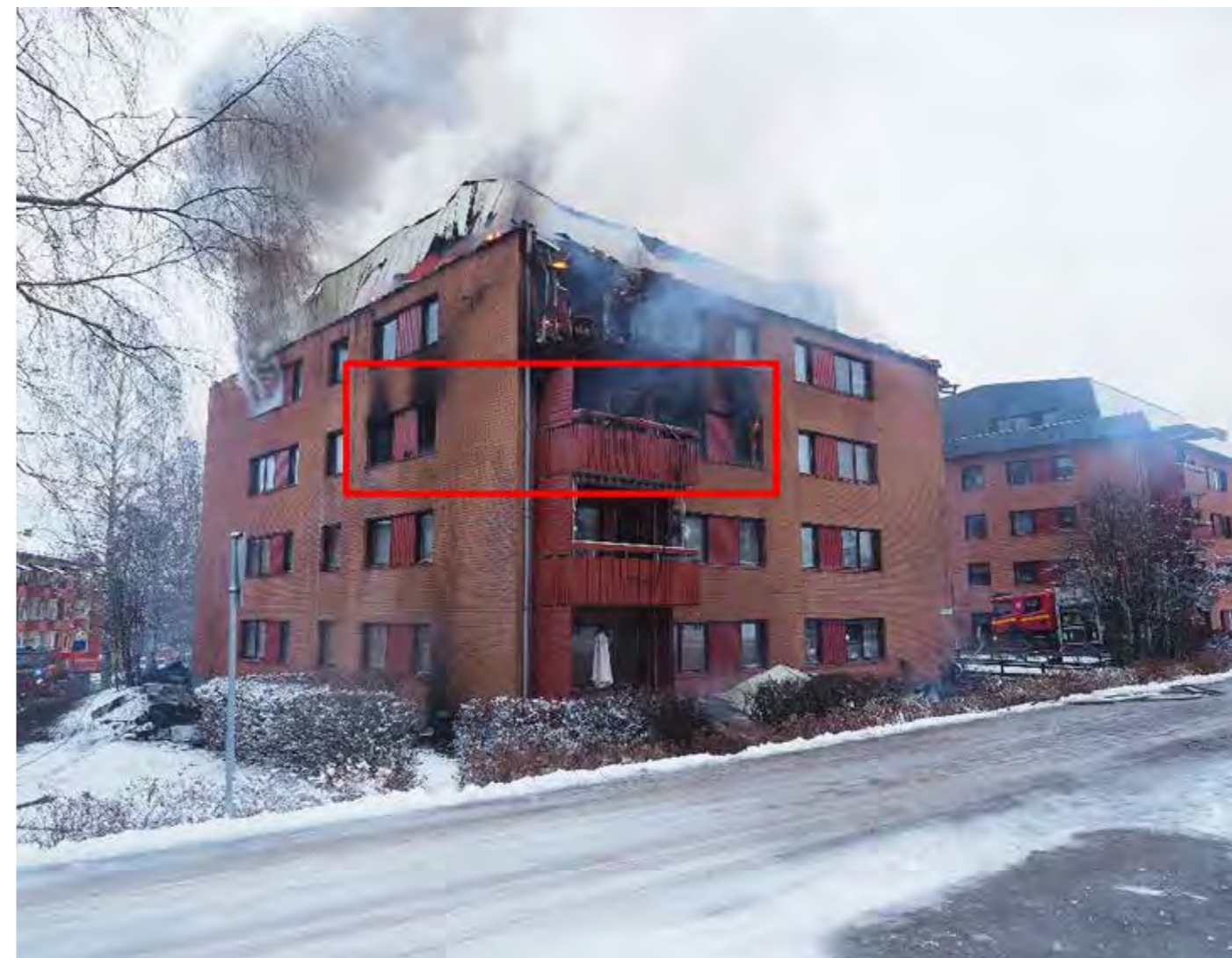
Branden startade på tredje våningen, spred sig snabbt via balkongen upp till fjärde våningen, och sedan till taket.
